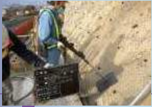
●アンカー削孔
