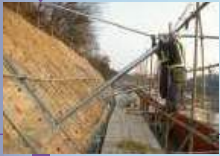
●支柱建て込み
