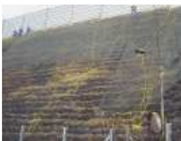
ネット取付状況
