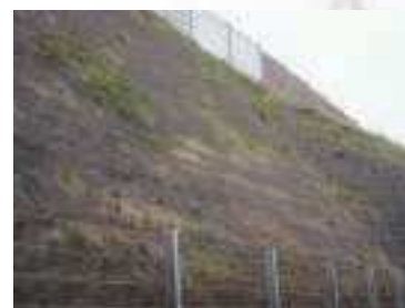
ネット取付完了
