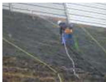
アンカーピン取付状況
