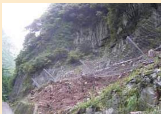
三重県南牟婁郡御浜町大字川瀬地内 林道川瀬奥線(落石対策工事)
