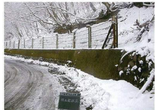
補強前の落石防護柵
