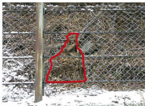
補強前の落石防護柵
